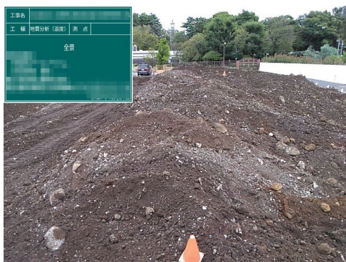
建設現場の残土
