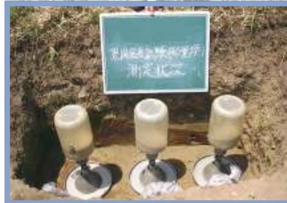
現場密度試験(砂置換)
